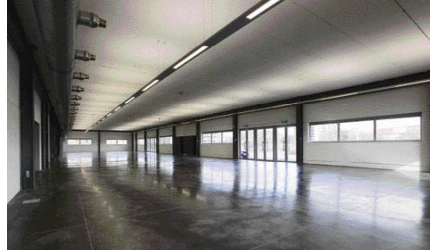
De structuur van het voorgebouw is berekend om er later eventueel een of twee lagen bovenop te zetten
